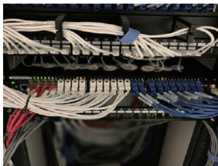
▲無線アクセスポイントへのPoE給電SWとしてEPS室に設置された「DGS-1250-52XMP」
