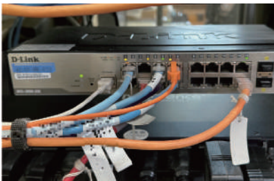
▲拠点スイッチとして設置された「DGS-3000-20L」
