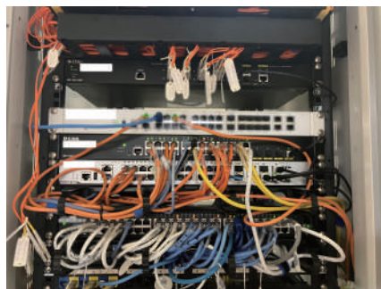
▲サーバールームに設置された「DGS-3630-28TCSI」と「DXS-1210-12SC」、「DGS-1250-28X」
