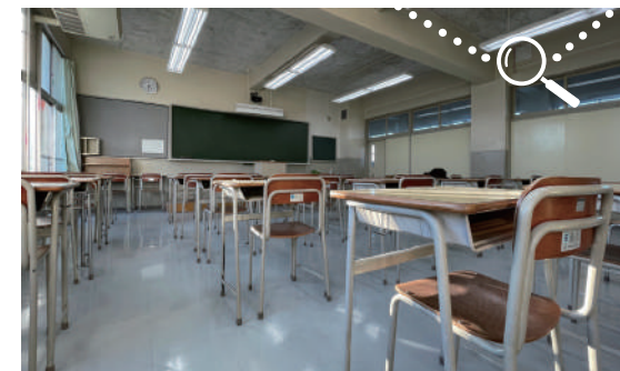
▲城西川越中高の本館には、すべての教室にアクセスポイントDBA-2520Pが1基ずつ設置されている。写真の教室では廊下側の高い位置にマウントされていた
