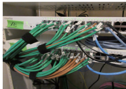
▲クラウド型ネットワーク管理サービス「Nuclias Cloud」に対応するギガビットL2スイッチ「DBS-2000-28MP」。無線AP「DBA-2520P」などに通信とPoE給電を行う
