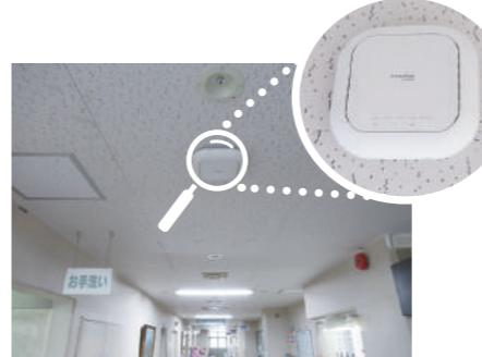
▲廊下の天井に設置されているNuclias Cloud対応の無線アクセスポイント「DBA-2520P」
