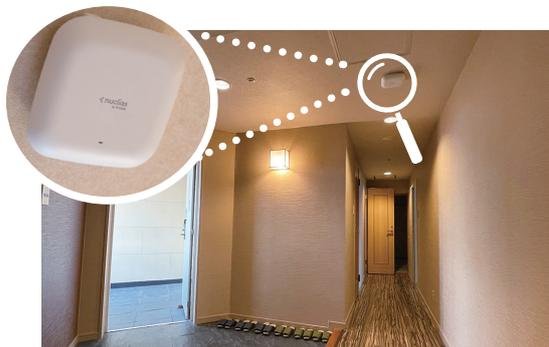
▲客室玄関付近の天井に設置されている、Nuclias Cloud対応のWi-Fi 6無線アクセスポイント『DBA-X1230P』
