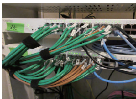
▲クラウド型ネットワーク管理サービス「Nuclias Cloud」に対応するギガビット L2 スイッチ「DBS-2000-28MP」。無線 AP「DBA-2520P」などに通信と PoE 給電を行う
