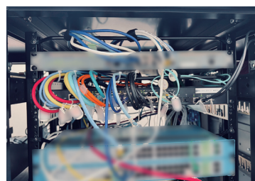
▲メタルポートで他のスイッチを収容する 「DXS-3410-32XY」
