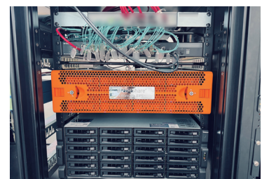
▲光ケーブルを集約し、EditShare EFSと バックアップ用のQNAPを収容する「DXS-3410-32SY」
