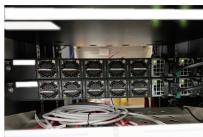
▲ サーバルームに設置された L3 スwitch（背面）
