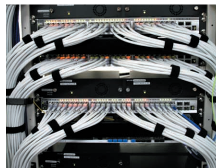
▲ ネットワークを統合管理するギガビットスタックアップスイッチDGS-3650
